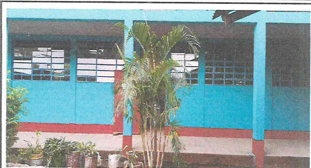
Foto 2: Mantenimiento a ventanales y cambio de vidrios.
