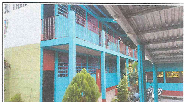
Foto 4: Pintura en exteriores.
