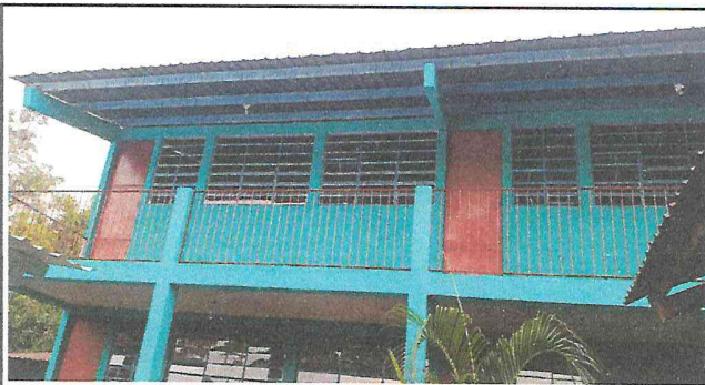
Foto 3: Mantenimiento a barandales.
